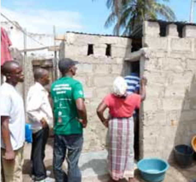
Revisión de la construcción de unas letrinas en Maputo (ISF Cataluña, 2011).
