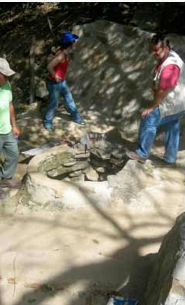
Reconstrucción de un pozo de agua para el proyecto Nizao III (ISF Andalucía, 2011).
