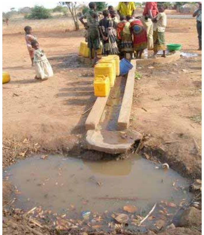
Problemas de drenaje en un punto de agua en Meza, distrito de Ancuabe
