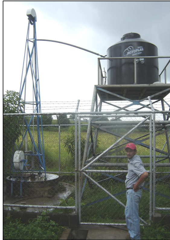
Bomba para elevación de agua en el municipio de Estelí que muestra el tipo de diseño que se busca para los centros de salud rurales de Cabo Delgado, Mozambique. Fotografía cortesía de Gabriel Rebassa.
